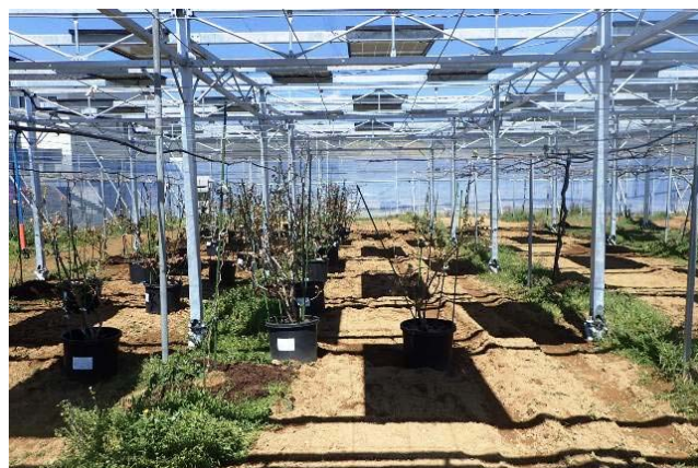
＜発電設備下に落ちるパネルの影＞
