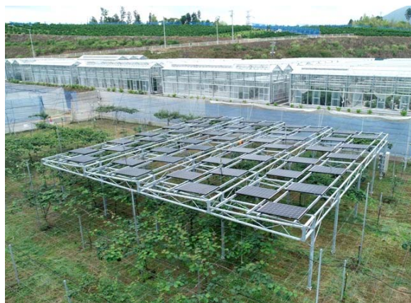
＜太陽光発電設備＞
